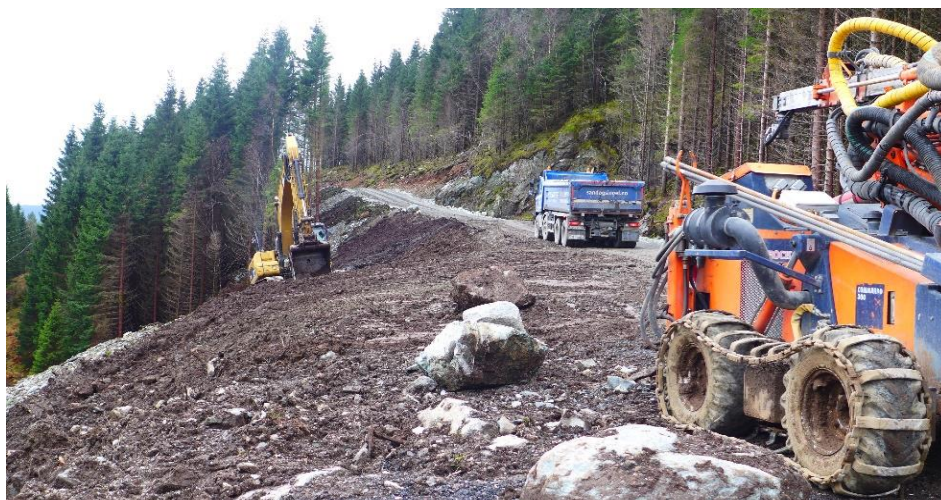
Skogsveibygging i Fanafjellet ved Bergen.
